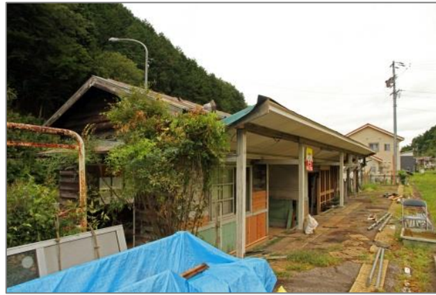
駅舎移設工事中(約 1600 mmホーム側に移設)…平成 26 年 8 月 3 日
