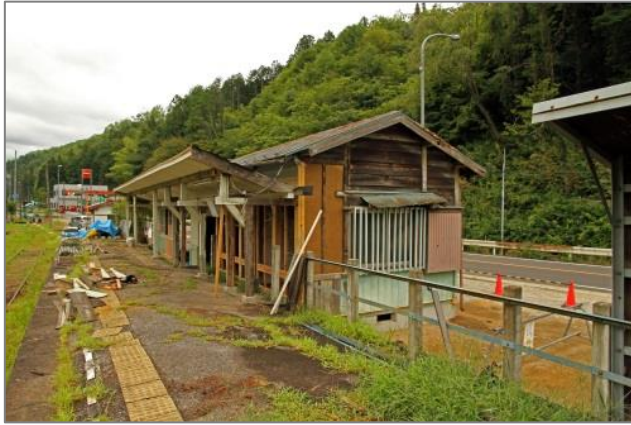
駅舎移設工事中(約 1600 mmホーム側に移設)…平成 26 年 8 月 3 日
