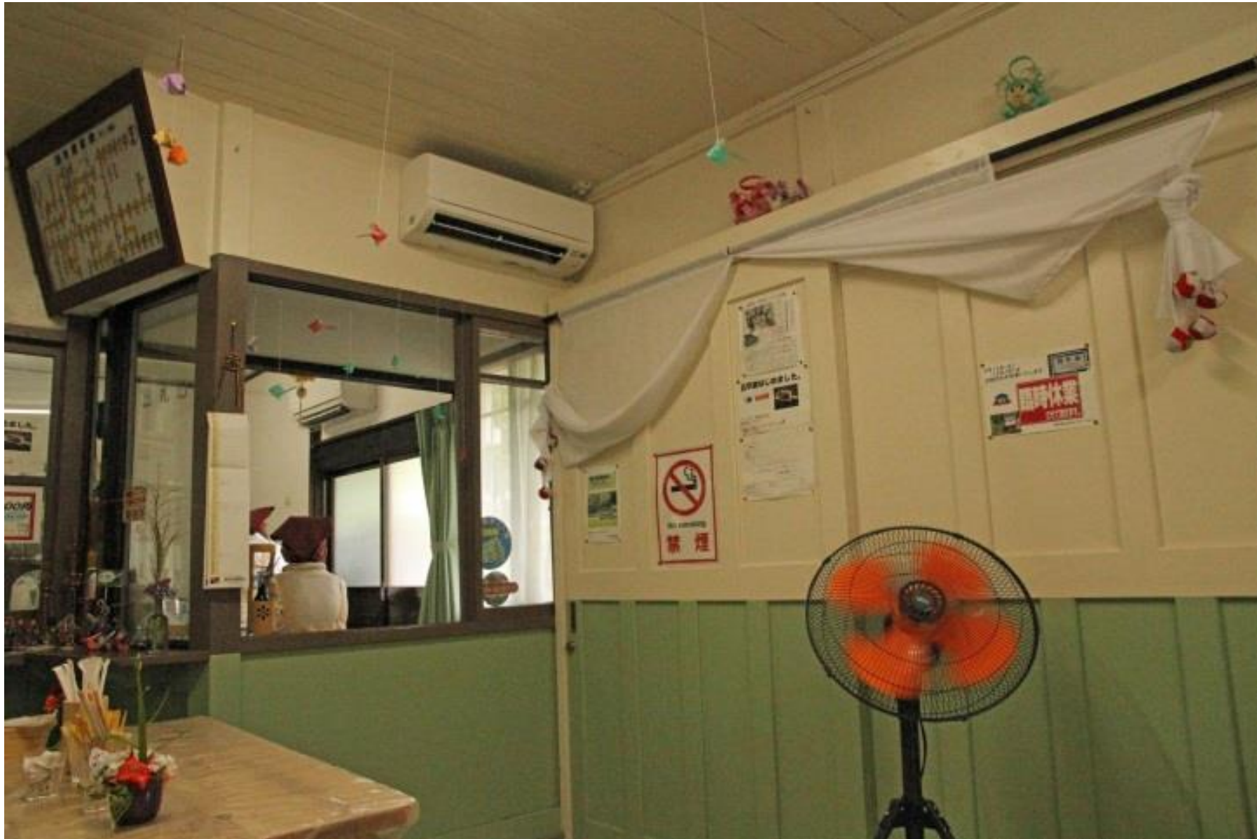
エアコン設置…平成 29 年 7 月 16 日
